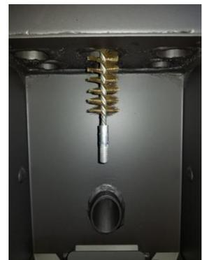
Das Auslassen der Wartung hat den Verlust der Garantie zu Folge. Wird der Ofen täglich benutzt ist die Reinigung aller Abgaswege alle 3 Monate durchzuführen.
